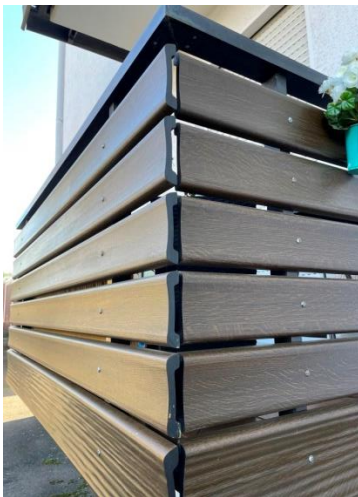
(2) Detail Balkonverkleidung
