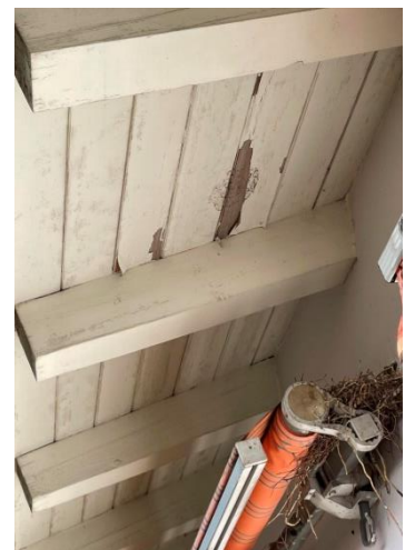
(21) Dachunterseiten müssen gestrichen werden
